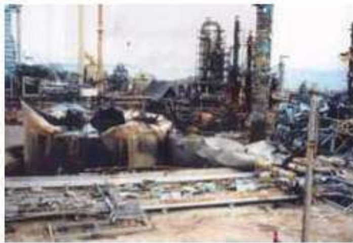
Figure 6 - Vue sur le bac B20
