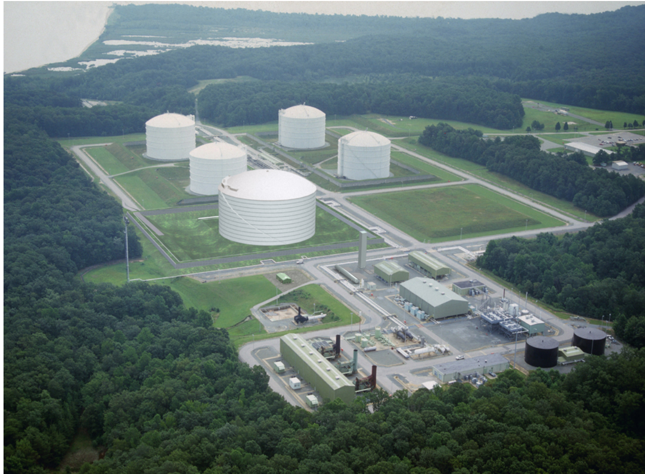
Single Containment LNG Tank
